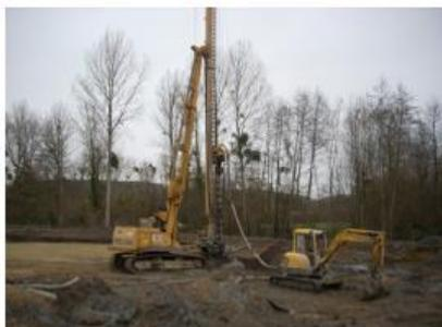
Cela a nécessité également de réaliser des fondations spéciales, 220 pieux d'une vingtaine de mètres ont été mis en place par forage et coulage de béton. On obtient ainsi une grande surface de contact entre les pieux et la tourbe et donc une bonne résistance par frottement.
