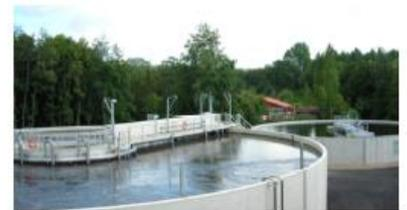
en périphérie, où l'on injecte de fines bulles d'air à travers une membrane. En mangeant les matières, les bactéries éliminent un maximum de carbone et dégagent de l'azote sous forme gazeuse, on le laisse sortir à l'air libre.
